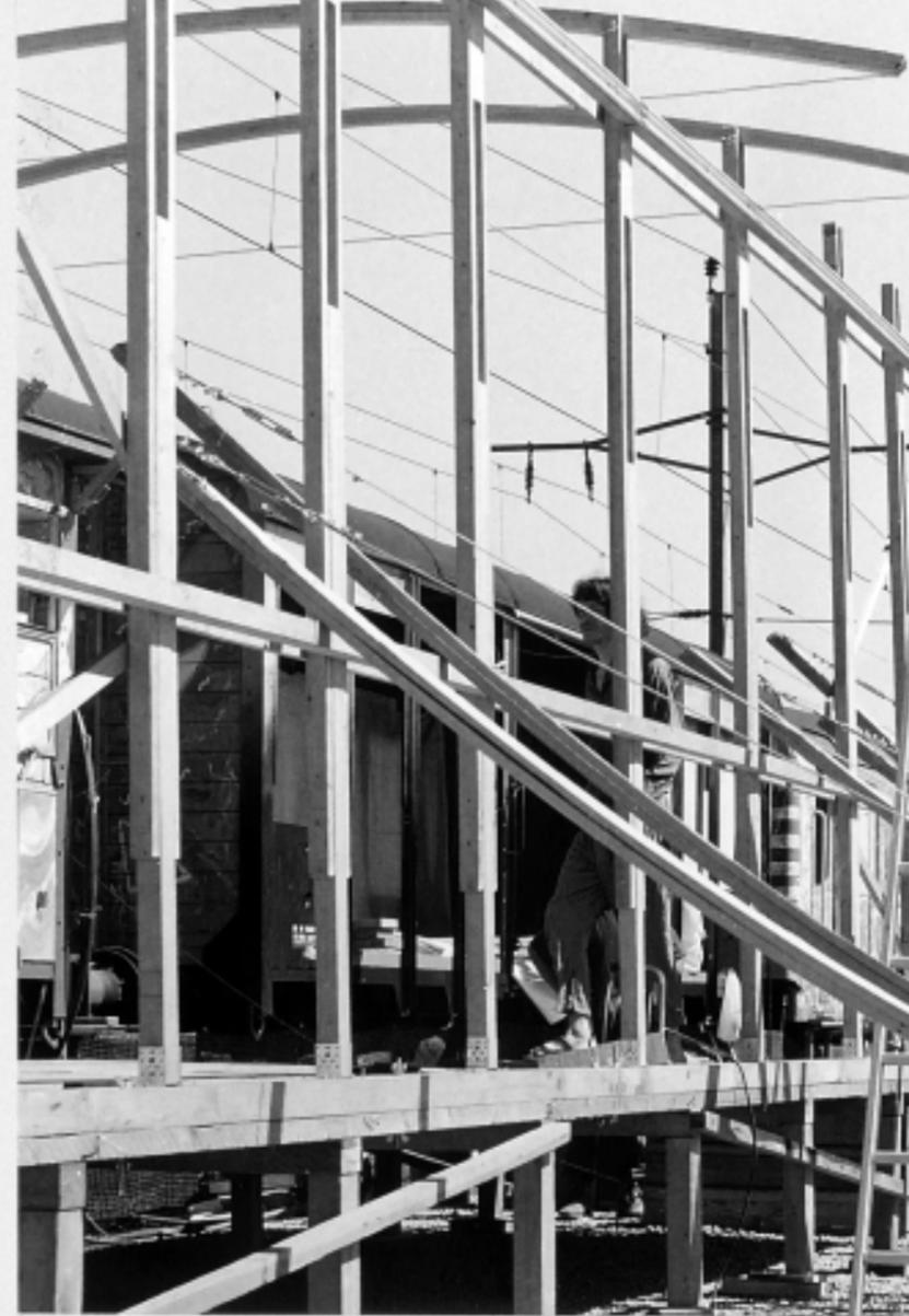
**Es lebe die Improvisation:** Ein Holzrost mit Zugangstreppe, säge und schraube zwischen zwei Wagen auf die Puffer montiert, dient als Duschplattform. Wichtig ist auch das Plastikdach, denn über uns sind die Stromdrähte der Fahrleitung. Nun wird *Cäsars Brause* mit Gartenschlauch am Küchenwagen angeschlossen. Der Wind vorbeirauschender Züge lässt die Duschvorhänge auffliegen; eiserne Gewichte am Saum bewahren die Intimsphäre.
